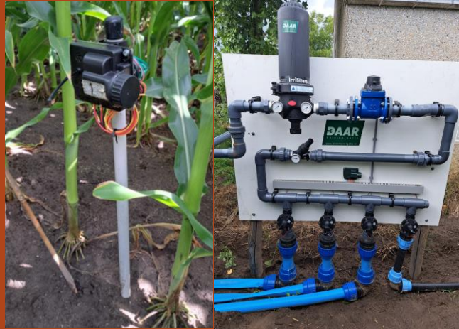
Figuur 1. Slim irrigeren vergt sensoren en aansturing. (Links: Watermarksensor met IOT-module in een maïsveld; Rechts: Irrigatiebord met filter, flowmeter, drukregelaar en aansturingsmodule gekoppeld aan 4 magneetkleppen)
