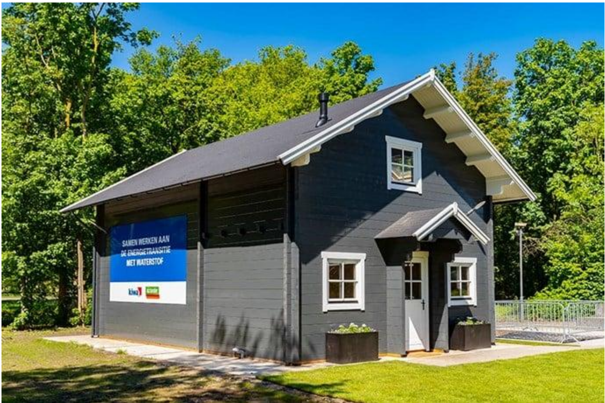
Figuur 3: Het waterstof huis van Kiwa en Alliander. Dit waterstofhuis wordt gebruikt als opleidingscentrum voor installateurs, maar ook als “experiencecenter”. [13]
