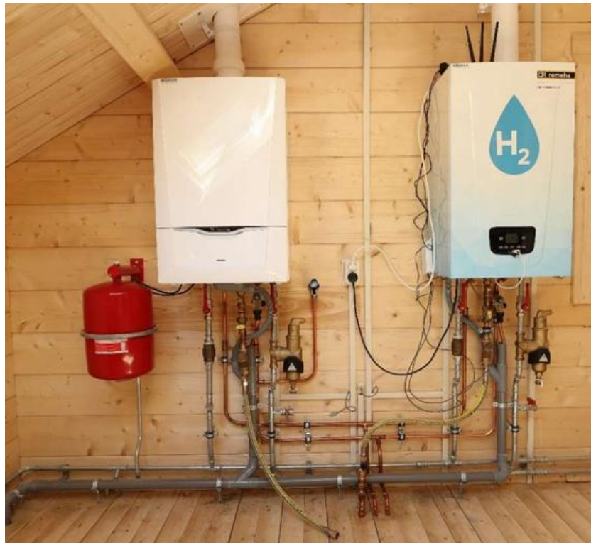
Figuur 1: Een waterstof cv-ketel (links) en een gewone cv-ketel (rechts). [1]
