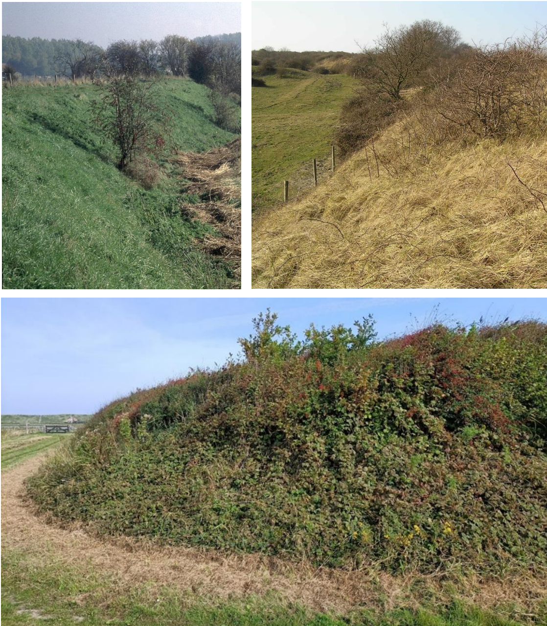
Figuur 20. Voorbeelden van dijktalud die in meer of mindere mate met struweel zijn begroeid.
