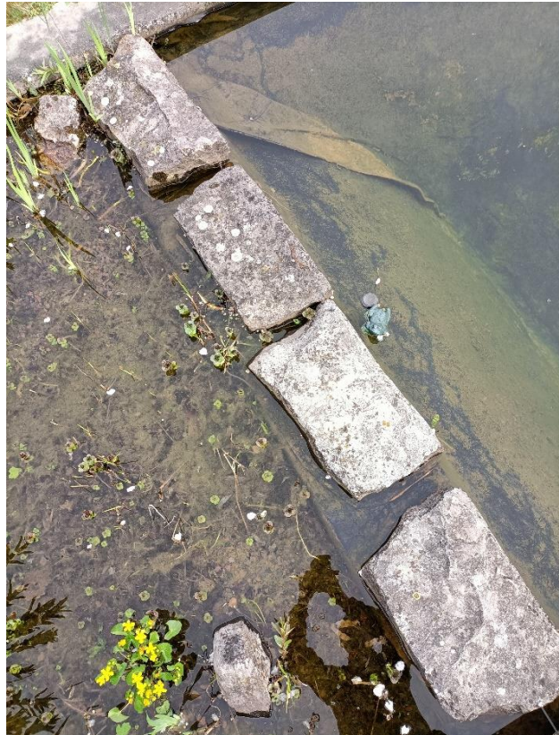
Figuur 32. Natuurlijke zwembijver. In een verhoogd deel staan water- en oeverplanten waarlangs water wordt geleid. Een richel houdt sediment tegen.
