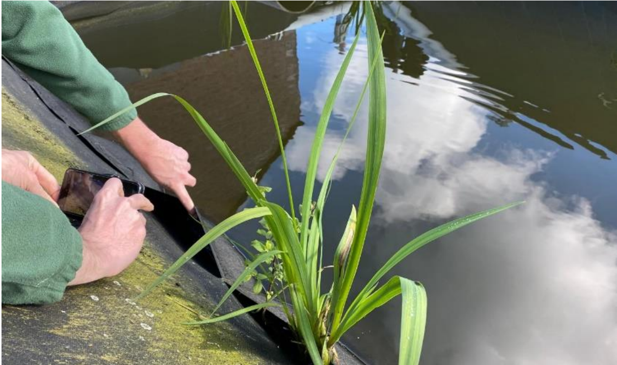
Figuur 35. Ballastzakken in bassinfoolie waarin spontaan waterplanten opkomen.
