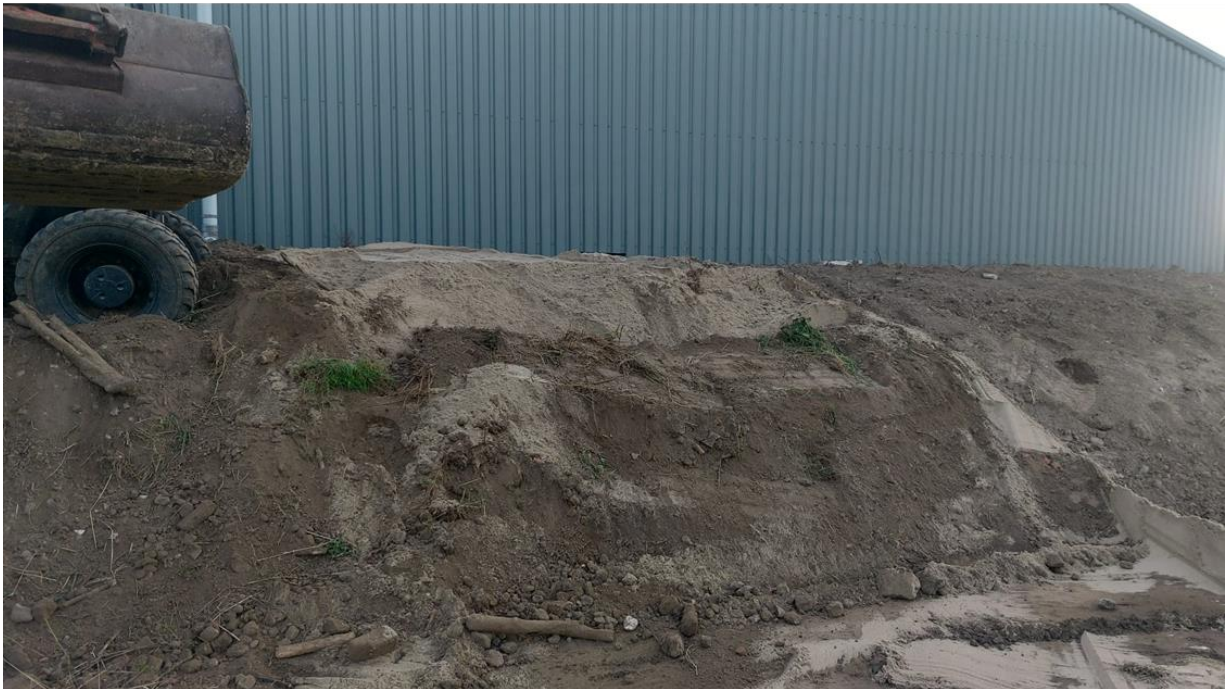
Figuur 24. Impressie van een aangepast talud: de oorspronkelijke kleiwal is afgegraven en vervangen door een zandwal.
