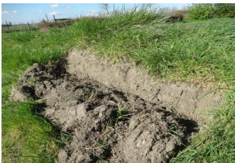
Figuur 23. Dijktalud waarin een stijlwand is aangebracht.
