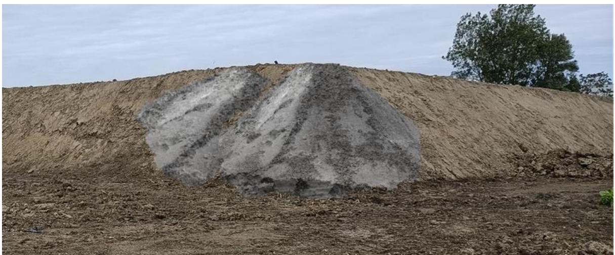
Figuur 17. Impressie van het gebruik van verschillende grondsoorten bij aanleg van een bassin. Hiermee wordt de vestiging van afwisselende vegetatie en fauna in de hand gewerkt.
