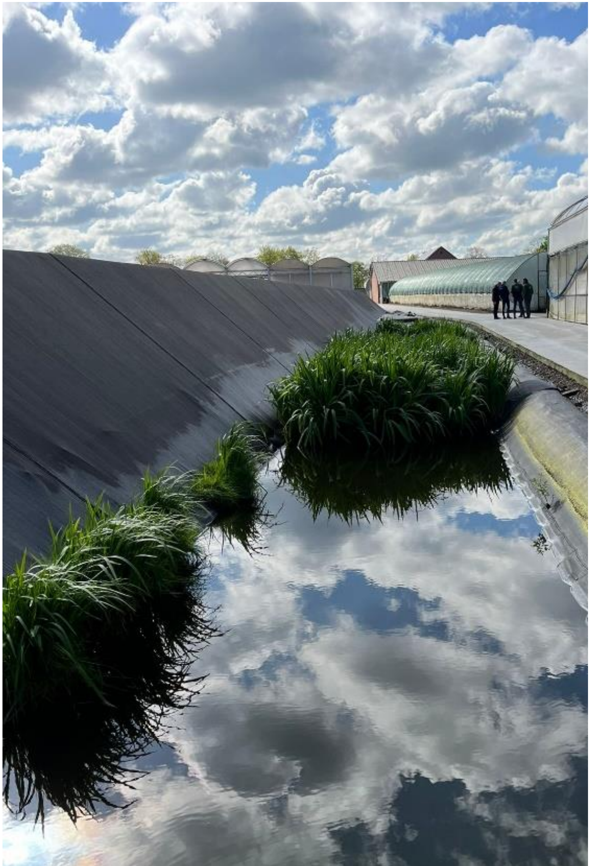
Figuur 38. Helofytensloot langs een bassin in Oosterland voor irrigatie van kassen. Hier zijn talud en sloot afgedekt met folie.
