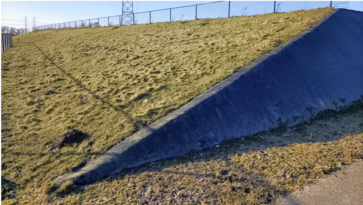
Figuur 16. Voorbeeld van een deels aangepast talud. Hier komt het contrast tussen een conventioneel, steil, met folie bedekt talud en een flauw talud met vegetatie goed naar voren.
