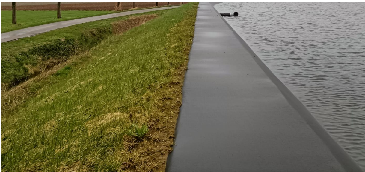
Figuur 13. Afdekfolie dat tot net over de kruin van het talud reikt. Hiermee blijft het buitentalud vrij voor de ontwikkeling van vegetatie.
