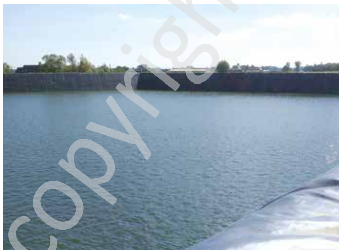
Het bekken van 150.000 m 3 wordt gevuld met gezuiverd afvalwater van Ardo en vormt een watervoorraad voor het komende irrigatieseizoen.
