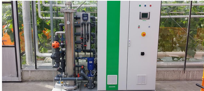
Figuur 1 a.) Chemische weergave van ozon ( O_3 ), b.) Ozoninstallatie voor waterbehandeling in de tuinbouw (bron: www.glastuinbouwwaterproof.nl )
