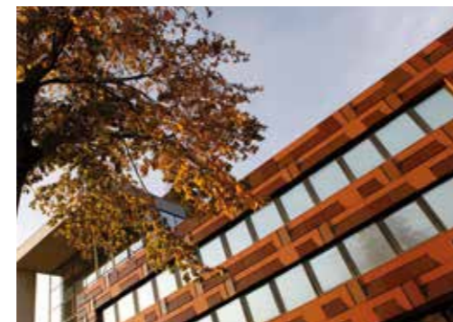
Decoratieve PV gevels met geïntegreerde LED verlichting (Solarix, Cube Architecten, Flexipol, Sorba en SCX Solar).
