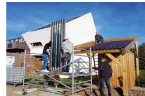
Figuur 4: Foto's van de plaatsing en realisatie van deze producten op het demogebouw.
