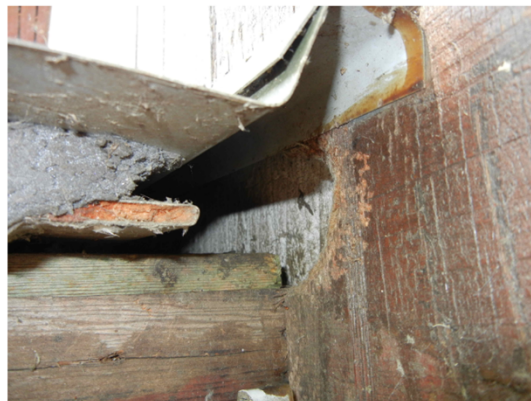
Opening bij de overgang van een plat dak naar een muur, waarlangs een steenmarter is binnengekomen © foto Sanne Van Den Berge
