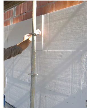
Afb. 101 Plaatsing van isolatieplaten met verspringende verticale voegen.
