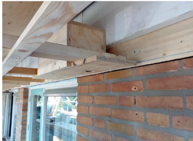
Vogelkast (maatwerk) in nieuwe en ruimere dakoverstek. Hierbij kan de invliegopening dicht bij de muur geplaatst worden zodat huismussen via de muur de invliegopening in kunnen (optimalisatie maatregel) (bron: Arcadis).
