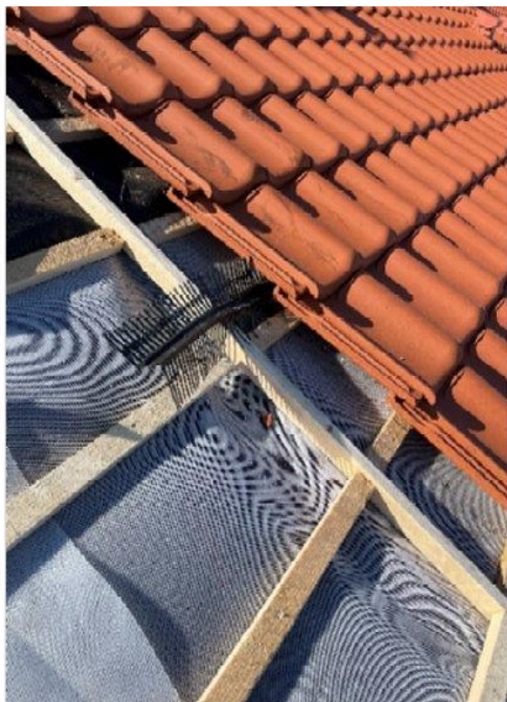
Figuur 2.6 Dakvlak geschikt gemaakt voor huismus, gierzwaluw en vleurmuizen.
