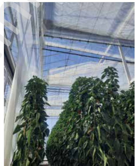
Op warme dagen kleven de folies aan elkaar, waardoor ze kunnen scheuren en loskomen. Er is dus nog verdere optimalisatie nodig.
