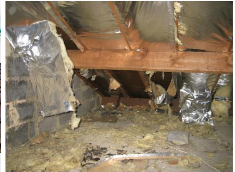
Schade aan dakisolatie door Steenmarter (Agentschap voor Natuur en Bos/ Lesley Peeters)
