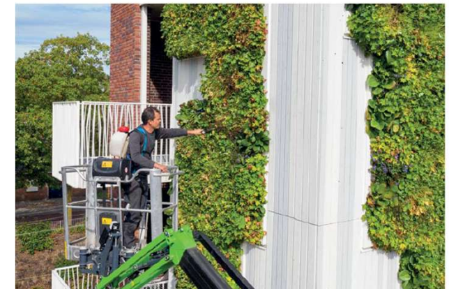
Afbeelding 39 Voorbeeld van het onderhoud van een groene wand.
