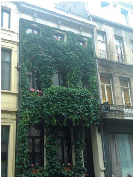
B. Een grondgebonden begroende gevel.
