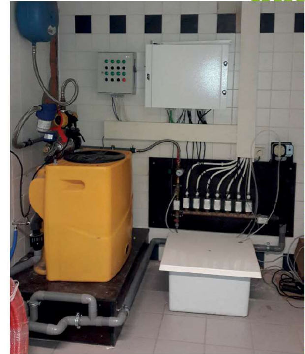
Afbeelding 31 Voorbeeld van een technische ruimte voor een groene wand (links: het gele buffervat, rechts: het witte opslagvat met voedingsstoffen) [W2].
