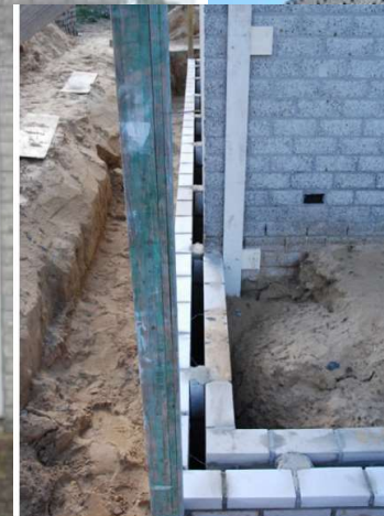
Figuur 2: Toevoegen extra spouwblad en portaal. Foto: Ruud Kaal
