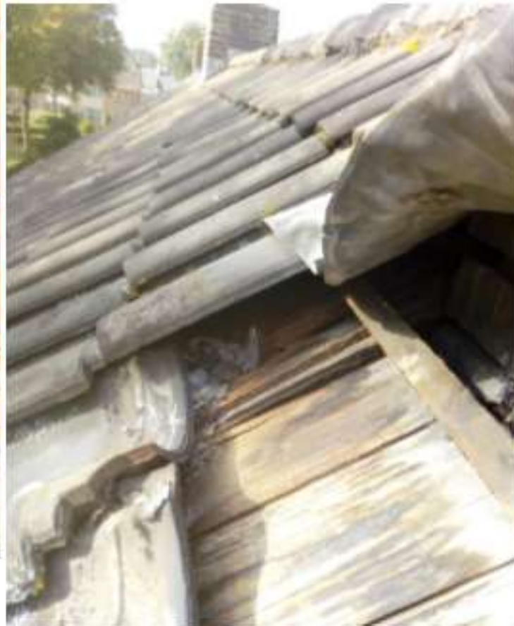
Figuur 2.6 Dakvlak geschikt gemaakt voor huismus, gierzwaluw en vleermuizen.
