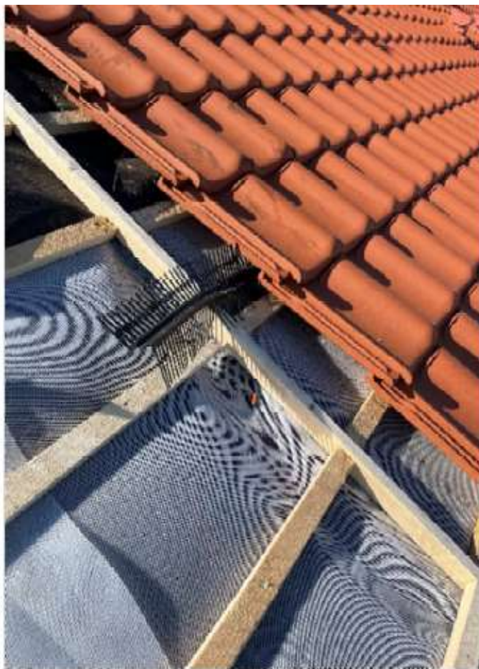
Figuur 2.6 Dakvlak geschikt gemaakt voor huismus, gierzwaluw en vleermuizen.
