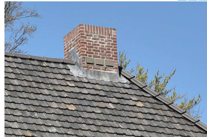
Entrestenen om een schoorsteen vleermuisvriendelijk te maken (bron: Vivara Pro).
