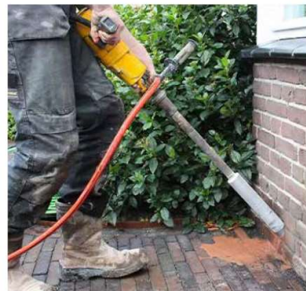
fig. 6 - close-up - luchtventilatie maken in bestaande kruipruimte
