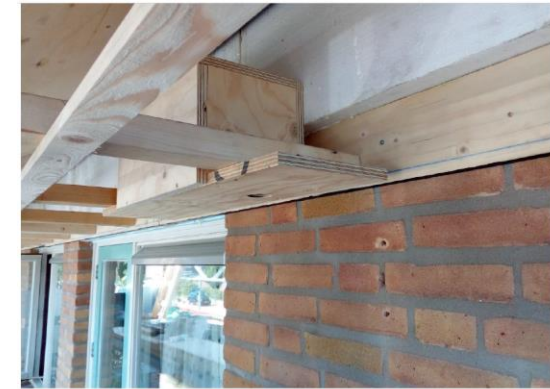
Vogelkast (maatwerk) in nieuwe en ruimere dakoverstek. Hierbij kan de invliegopening dichter bij de muur geplaatst worden zodat huismussen via de muur de invliegopening in kunnen (optimalisatie maatregel) (bron: Arcadis).
