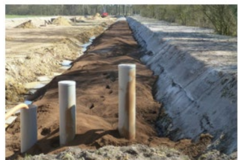
Figuur 3. Ijzertzandfilter de Groote Meer van 240 m lang
