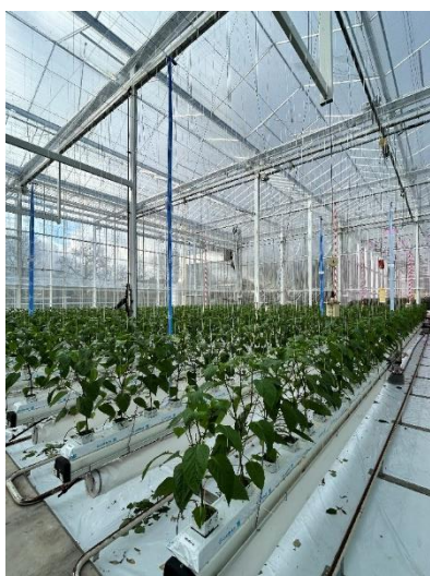
Fig. 4 Invoer verse lucht via luchtkanaal
