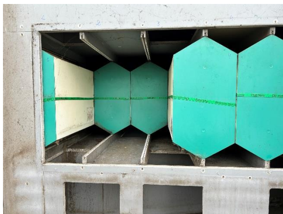
Fig. 5 Parallel geschakelde warmtewisselaars
